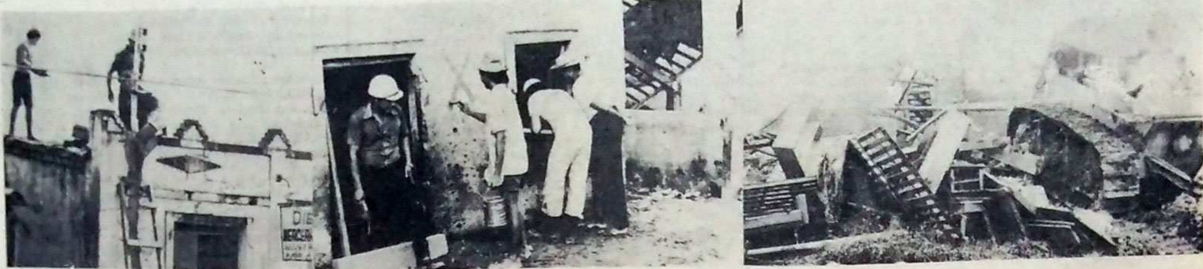
Primeiro, a oportunidade de todos retirarem o que puderem: depois, a avaliação do imóvel, com a colocação de um "x" em vermelho, para efeito de identificação; e finalmente, os tratores, que estão derrubando cerca de mil casas. No local, será construído um lago de oxidação.
