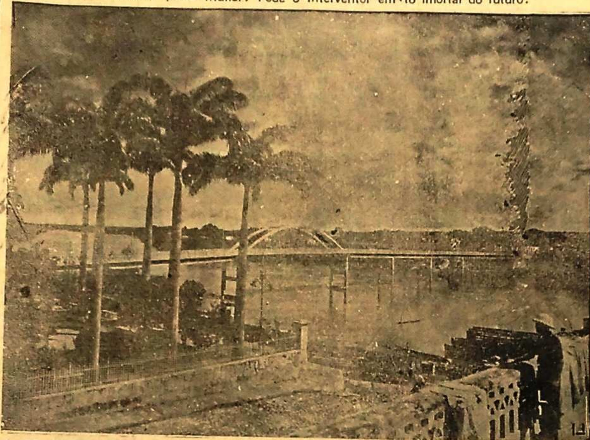
A PONTE BACHAREL JULIO MÜLLER, VENDO-SE À DIREITA, O ENGENHEIRO DA FIRMA COIMBRA BUENO, DR. CASSIO VEIGA DE SA, CONSTRUTOR DA OBRA
